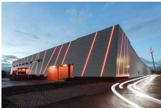
Das Einkaufszentrum Schwarzwald-Baar-Center in Villingen-Schwenningen sollte durch eine neue Massiv-Sandwichfassade mit Lichtelementen aufgewertet werden. Die Vorgaben der Architekten konnten einfach und unkompliziert in bocad zur Grundlage der Konstruktion übernommen werden.
